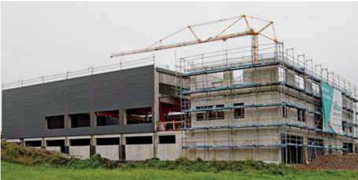
Lerchenmüller baut an der A 7 im Gewerbegebiet Dietmannsried. Im Januar will der Spezialist für Flachdachbau von Altusried an seinen neuen Firmensitz umziehen.
